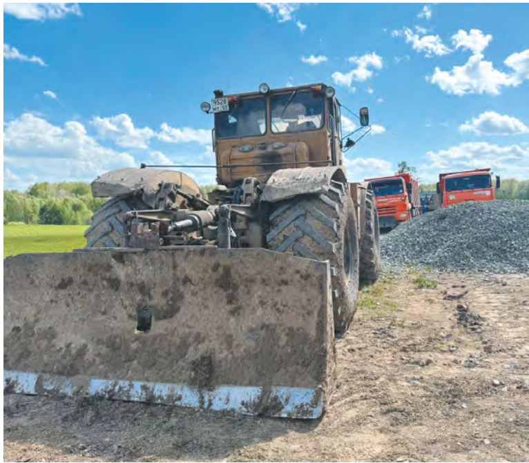
В дорожных работах задействована техника ДРСУ-5.
