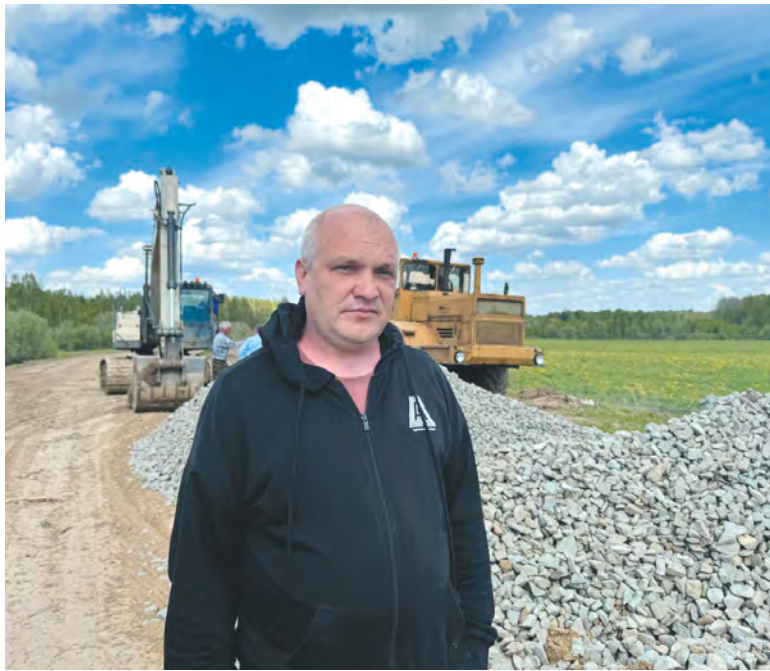
Бригадир Алексей Махонин надеется, что погода позволит завершить ремонт дороги в ближайшее время.
