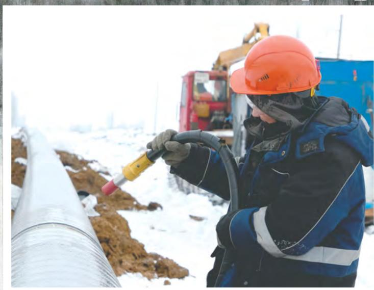
Идет пескоструйная очистка сварного соединения.
