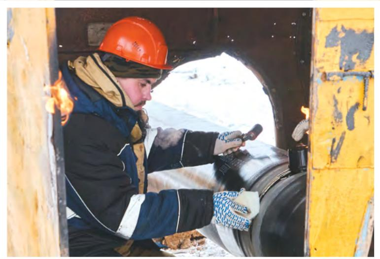
После очистки сварного соединения на него наносят праймер, потом манжету.
