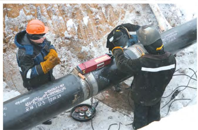
Рабочие соединяют трубы с помощью ручной сварки.
