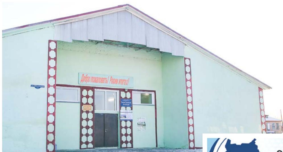
Выполнен капитальный ремонт Б-Туралинского СДК
