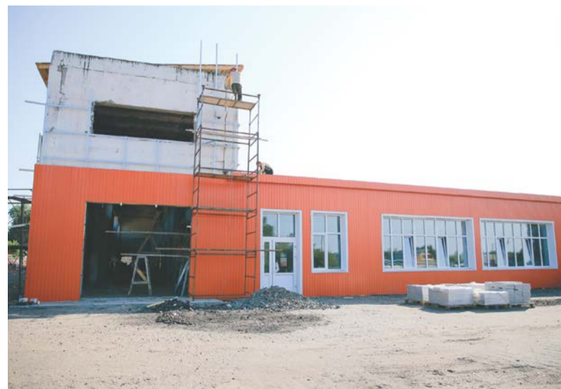
Взять полуразрушенные производственные помещения, отре- монтировать их, чтобы впоследствии открыть в них магазин ме- бели, решил предприниматель Сергей Конашов.
