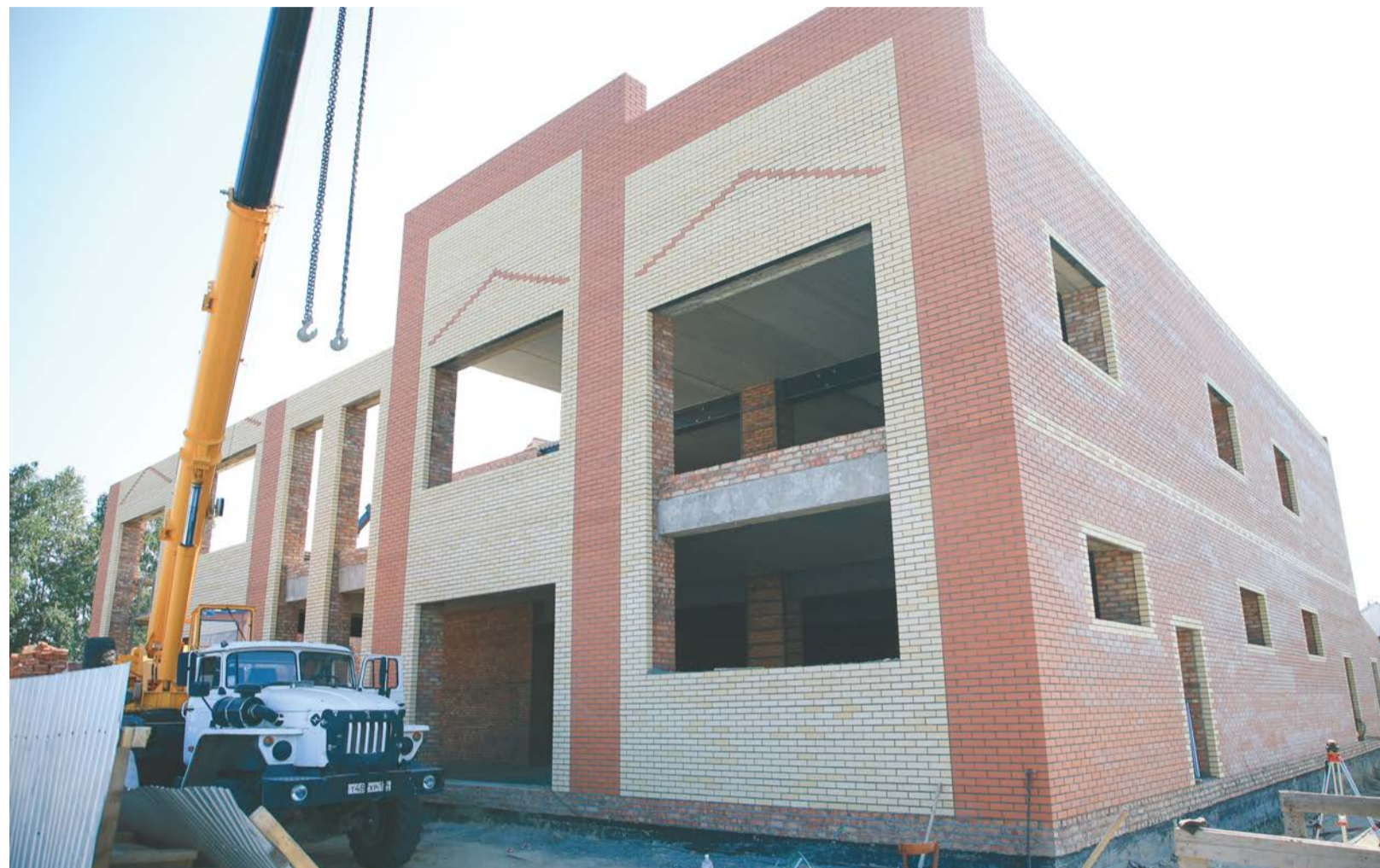
Двухэтажное кирпичное здание на перекрестке улиц Избышева и Ленина, на месте снесенной бревенчатой двухэтажки, возводит предприниматель из Новосибирской области.
